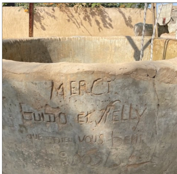
Dit is de eerste put, die manueel bediend wordt, de putten op het grote terrein werken met pomp en zonnepanelen. Op de put staat gegrift in beton: MERCI GUIDO ET NELLY QUE DIEU VOUS BENI
